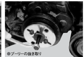
●プーリーの抜き取り
